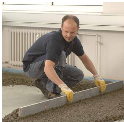
Укладка легкого выравнивающего раствора UZIN NC 194 Turbo
