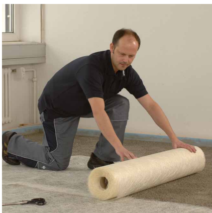
Раскладка ремонтного полотна UZIN RR 201
