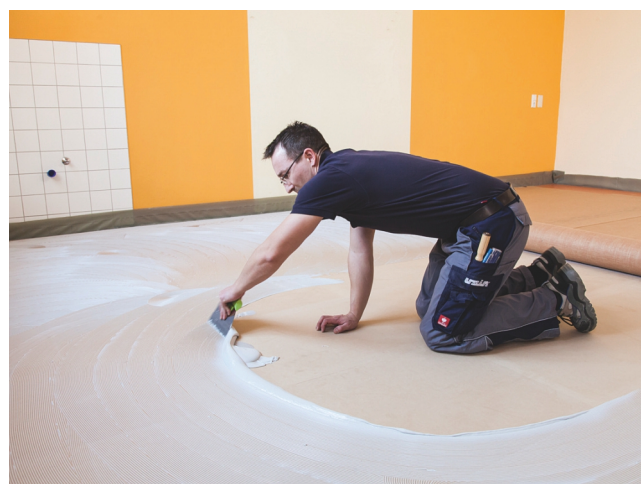
Укладання лінолеуму на систему UZIN RenoTop PLUS за допомогою клею UZIN LE 44.
